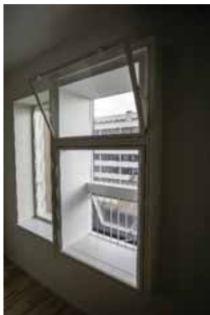
Figur 22. Støjdæmpende multifunktionsvindue (billederne til venstre og i midten). Støjen dæmpes på vejen gennem åbningen for nedenunder (udendørs) til åbningen for oven (indendørs). Til højre er vist en lydskodde, som er monteret foran et eksisterende vindue. Den dæmper støjen, men giver også adgang for frisk luft. Den kan desuden mørkelægge et rum, hvis det ønskes.
