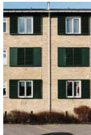
Figur 22. Støjdæmpende multifunktionsvindue (billederne til venstre og i midten). Støjen dæmpes på vejen gennem åbningen for nedenunder (udendørs) til åbningen for oven (indendørs). Til højre er vist en lydskodde, som er monteret foran et eksisterende vindue. Den dæmper støjen, men giver også adgang for frisk luft. Den kan desuden mørkelægge et rum, hvis det ønskes.
