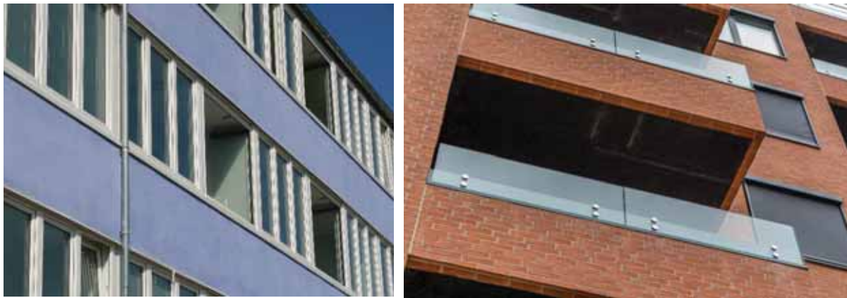
Figur 23. I ejendommen til venstre blev altanerne forsynet med en forsatsrude, der kan skydes til siden. Når ruden er lukket, fungerer den sammen med altanrummet som en meget effektiv støjdæmpning. Til højre er vist åbne altaner med en glasafskærmning, der begrænser støjen. Der er desuden et lydabsorberende akustikloft, som dæmper støjen i altanrummet.
