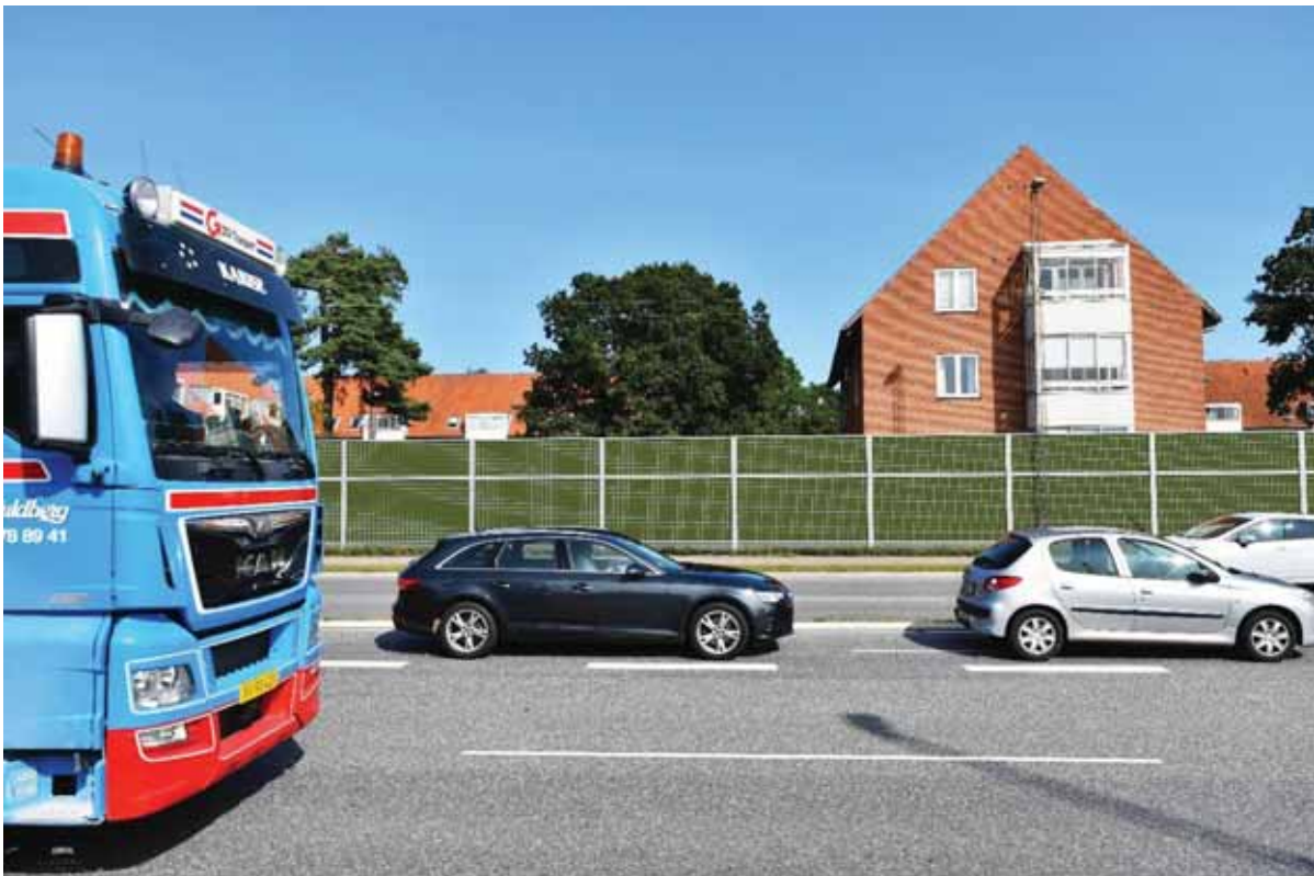
Figur 18: Eksempel på støjskærm ved et etageboligområde. Støjskærmen dæmper støjen på de udendørs opholdsarealer bag skærmen og for boligerne i stueetagen, men ikke for boligerne på 1. og 2. sal.
