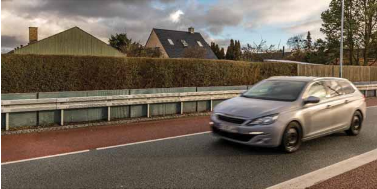
Figur 17. Autoværn, der er udformet som en lav støjskærm. Selvom skærmen er lav, kan der være en støjdempende virkning, fordi den står meget tæt på støjilden (Vejlegårdsvej, Vallensbæk Kommune).
