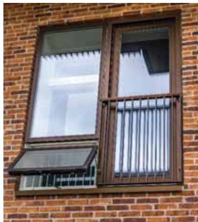
Figur 22. Støjdæmpende multifunktionsvindue (billederne til venstre og i midten). Støjen dæmpes på vejen gennem åbningen for nedenunder (udendørs) til åbningen for oven (indendørs). Til højre er vist en lydskodde, som er monteret foran et eksisterende vindue. Den dæmper støjen, men giver også adgang for frisk luft. Den kan desuden mørkelægge et rum, hvis det ønskes.
