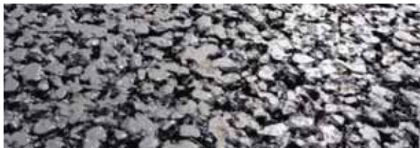
Figur 14. Nærbillede af et nyt og mindre støjende slidlag (teknisk betegnelse: SMA-8). Både den meget jævne og åbne overfladestruktur ses tydeligt. En traditionel belægning (f.eks. SMA-11) har en grovere og mere ujævn struktur.
