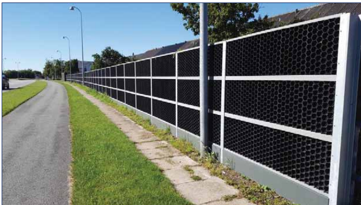
Figur 15. Eksempel på støjskærm langs et boligområde. De sorte akustiske elementer i skærmen består af materiale fra genbrugte vindmøllevinger (Vallensbæk).
