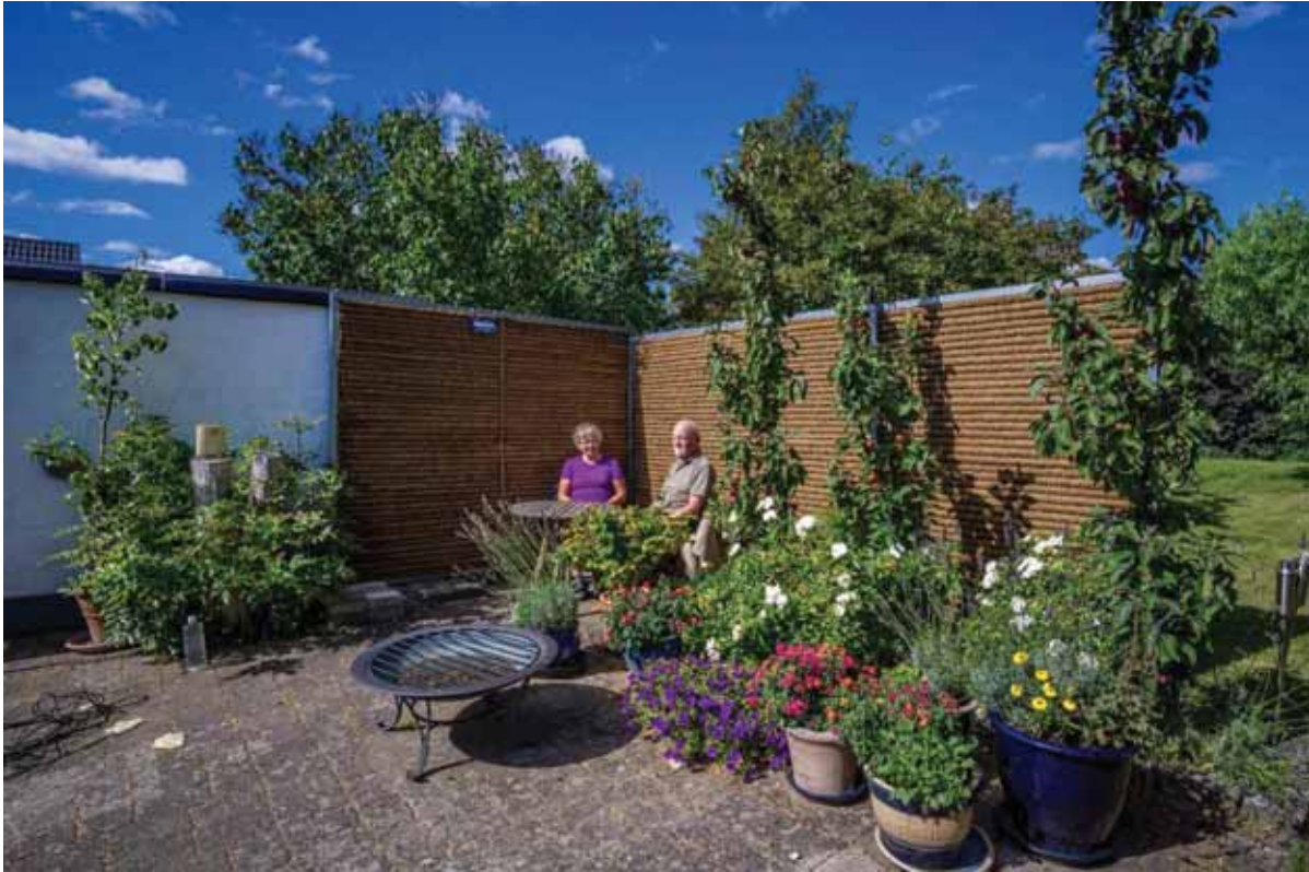
Figur 25. Et støjhegn kan skabe en støjafskærmet krog eller terrasse. Den støjdæmpende virkning kan opleves i et mindre område lige op af hegnet (fra en forsøgsopstilling i en have i Glostrup).
