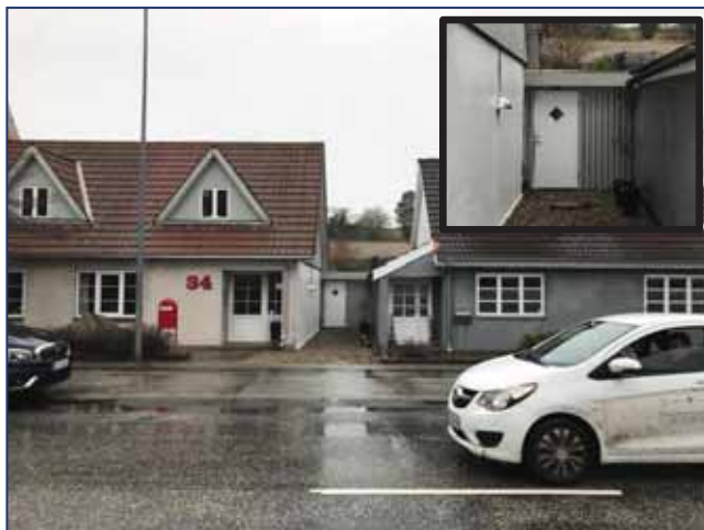
Figur 27. Boligerne skærmer for støjen, men der kommer støj ind gennem smøgen mellem de to huse. Ved at sætte et hegn (her også med en dør) i smøgen, er støjen i baghaven dæmpet mærkbart.
