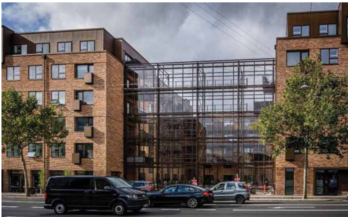
Figur 21. I denne nye bebyggelse, har man anvendt en støjskærm i åbningen mellem bygningerne for at opnå et lavt støjniveau i bebyggelsens gårdmiljø. I facaden mod vejen er der anvendt særligt støjdæmpende vinduesløsninger (Gl. Køge Landevej, København).
