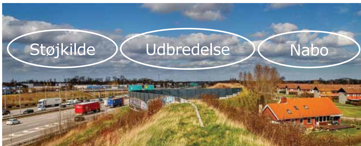
Figur 13. Dæmpning af trafikstøj kan ske ved brug af redskaber, der er rettet mod støjkilden, støjens udbredelse og modtageren, det vil sige vejens nabo.
